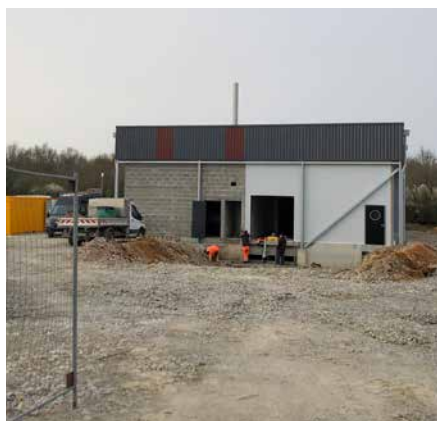
▲ Construcción del nuevo edificio Mussella 2
